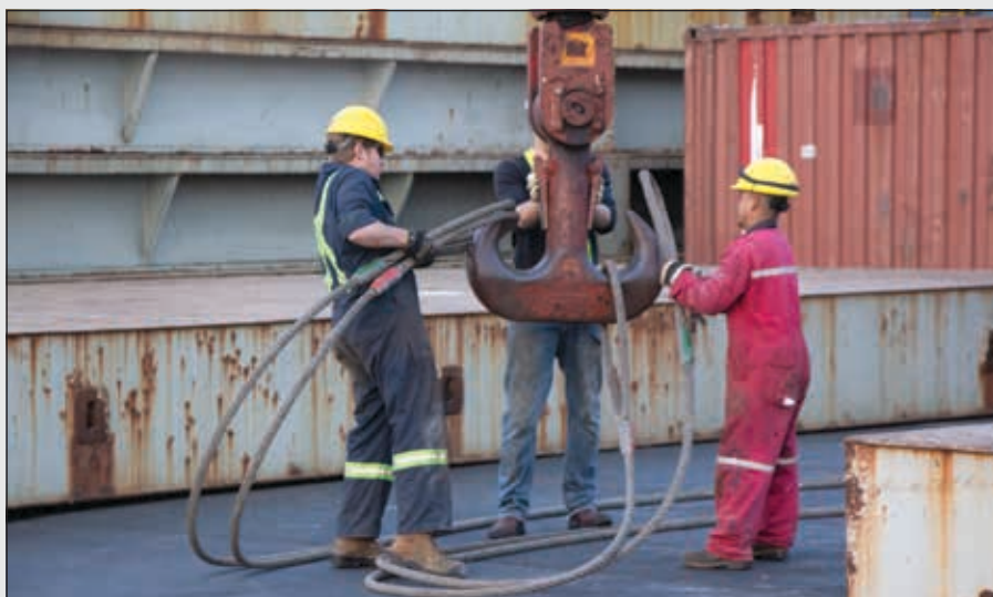
Rosaire A. Desgagnes (putting wires on crane)
