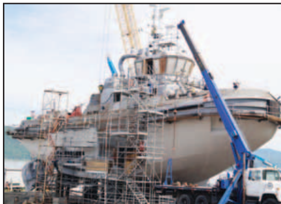
Vue du TundRA 100 en construction View of the TundRA 100 under construction
